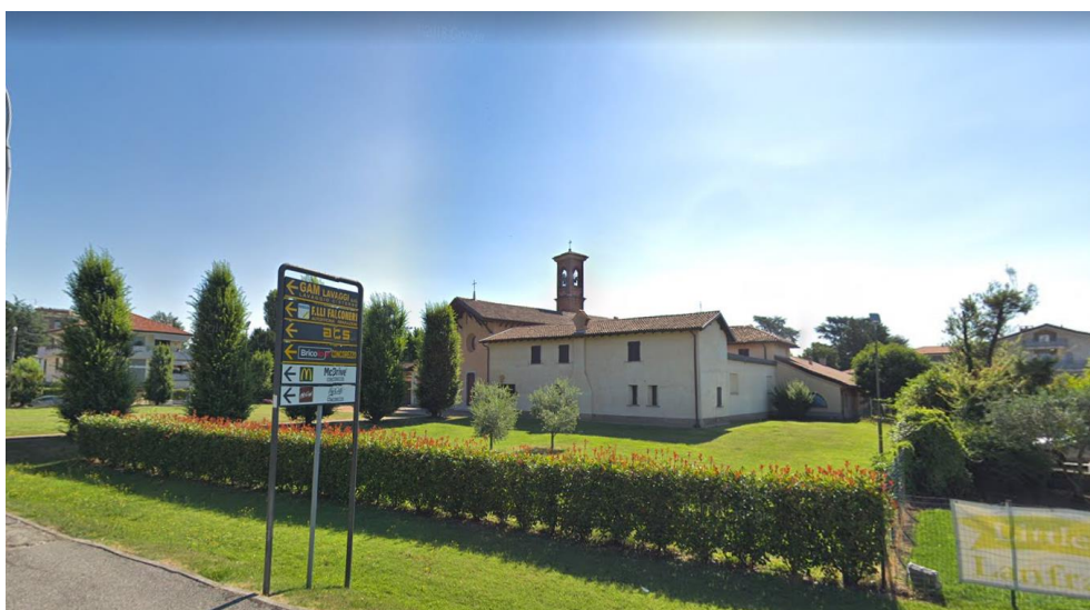
1.40 Immagine esempio stralcio del tessuto urbano dell'area da includere A2 Fonte: Google maps street view
