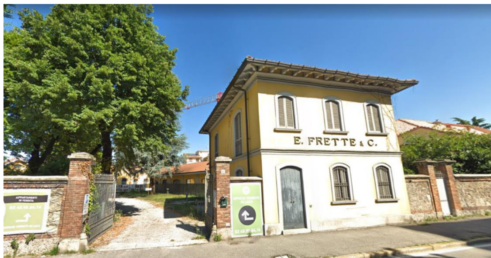
1.36 Immagine esempio stralcio del tessuto urbano dell'area da includere A1 Fonte: Google maps street view
